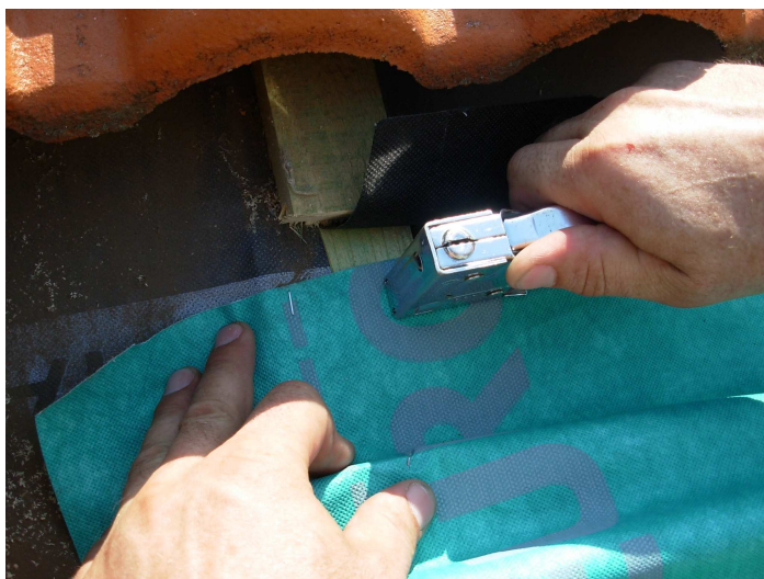
A fólia csíkot az elvágott ellenléc helyén a szarufára is rögzíteni kell a tetőfólia alatt.
