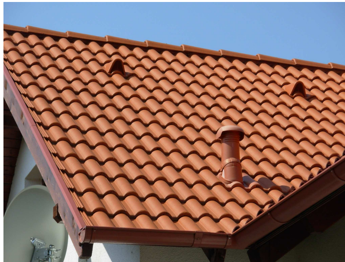
tető lakótérre történő kialakítása, tetőtéri ablak beépítése előtt (külső nézet)
