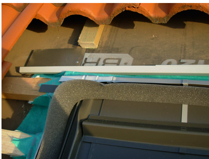
kétoldali ragasztóval egy szivacsos elemet helyezünk fel.
