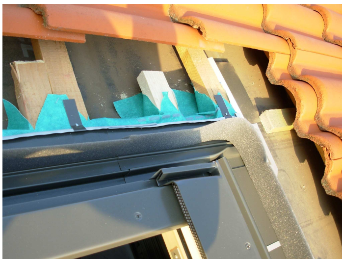
A burkolókeret két oldalsó és a felső elemének csapadékvezető peremének külső részére
