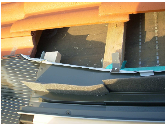
A burkolókeret két oldalsó és a felső elemének csapadékvezető peremének külső részére
