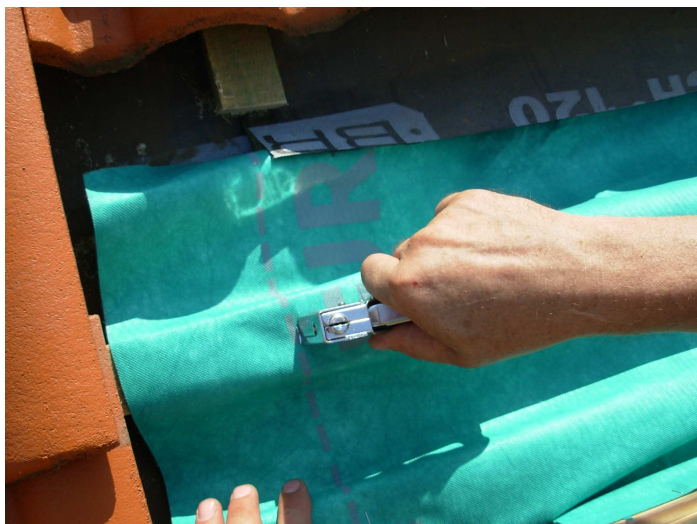
A segédfóliát rögzítjük az ablak fölötti cseréplécre tűzőgéppel.
